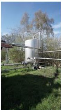
Hier wird die Kohlensäure konzentriert und vom Wasser abgeschieden. Danach über gelangt sie über Rohrleitungen in die Reinigung und Verdichtung.
