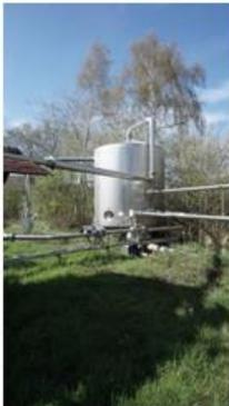
Hier wird die Kohlenensäure konzentriert und vom Wasser abgeschieden. Danach über gelangt sie über Rohrleitungen in die Reinigung und Verdichtung.
