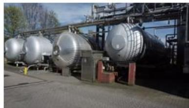
Kohlensäuretanks der fertig aufbereiteten und versandfertigen Kohlenensäure
